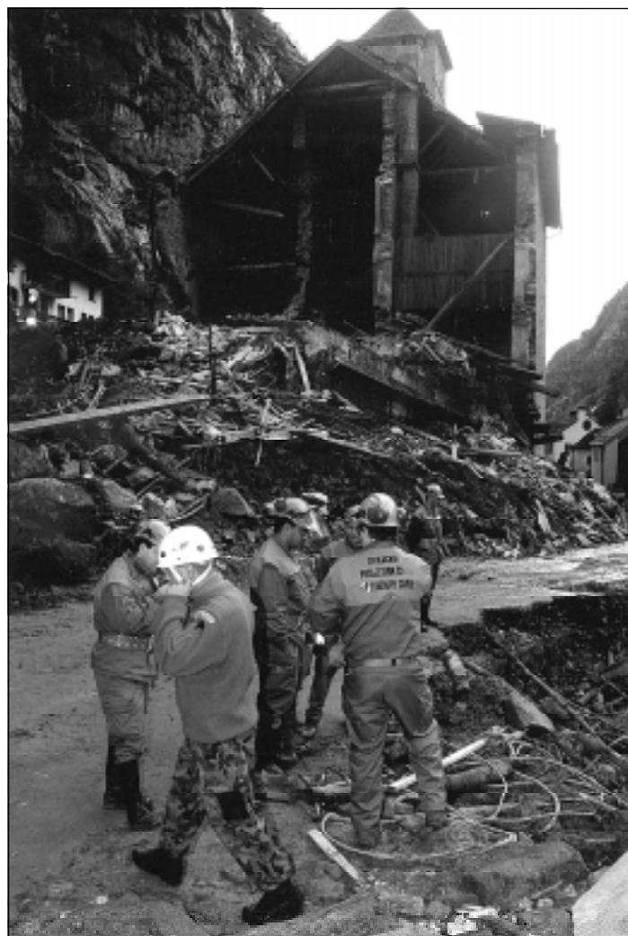
Den Angehörige der Armee und des Zivilschutzes bot sich in Gondo ein Bild der Verwüstung. Im Hintergrund der halb zerstörte Stockalperturm.
