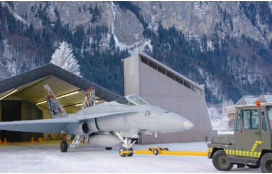
Gebäude für Triebwerkstestläufe.
