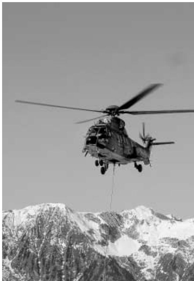
Fünf Kubikmeter Beton fürs Fundament. Mit einem «Super Puma» der Armee wurde das Baumaterial für die kanadische Blockhütte eingeflogen.
